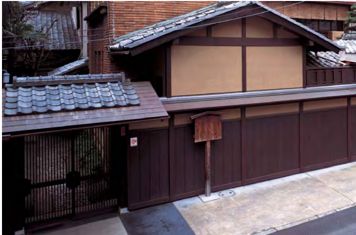
↑ 通りに面した店の部分や蔵が、外から入る熱をふせいでいます。
