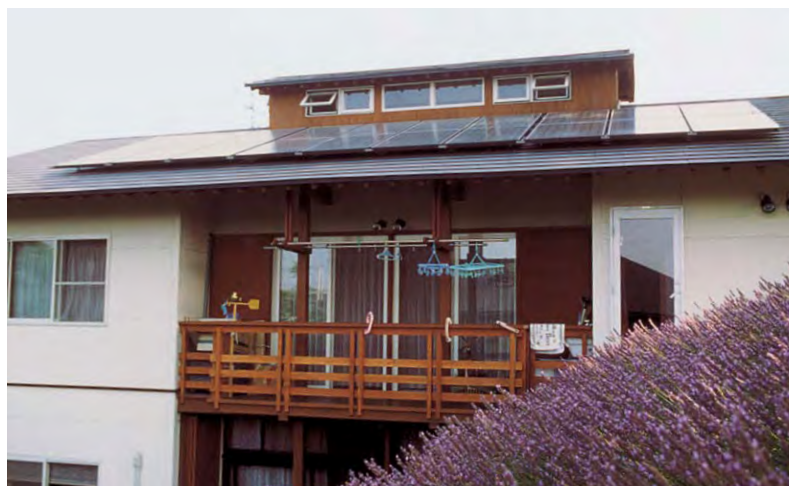
↑ 壁や窓などに断熱のくふうをし、太陽光発電を利用しています。
