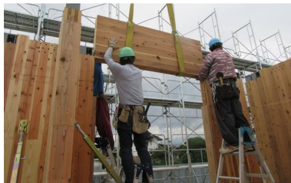
西棟：壁パネルの建て方工事
